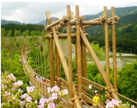
わんぱく大橋(吊り橋)
